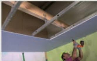
Ces plafonds sont constitués de plaques de plâtre BA 13 vissées sur une ossature métallique reliée à la charpente ou au plancher par des suspentes. Le vide ou "plénum" entre le plafond et la structure permet d'incorporer l'isolant, les réseaux de spots basse tension, trappes de visite, dissimuler les fils électriques, gaines, etc.
