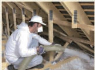
La laine minérale en flocons est mise en œuvre par soufflage mécanique.
