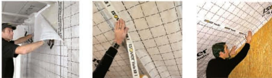
La membrane adhère facilement aux parois maçonnées (parpaings, briques...), elle se pose par marouflage sur la paroi à l'aide d'une brosse ou d'un balai pour en finaliser l'adhérence.
