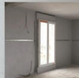
Ce procédé s'applique par projection directe sur les murs maçonnés dit "froids" de la zone chauffée. La projection doit être effectuée au moment de la construction "hors d'eau / hors d'air" et peut se faire avant (câbles électriques et fluides positionnés) ou après la pose des plafonds en plaques de plâtre.
