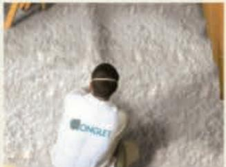
Adaptée à l'isolation thermique et acoustique des bâtiments résidentiels ou tertiaires, en neuf ou en rénovation.
